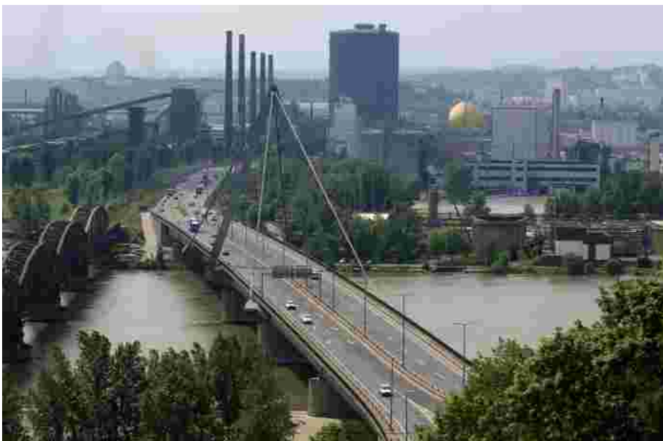
Foto 17004: Linzer Industriegebiet mit Voest-Brücke © Hans Kosina
