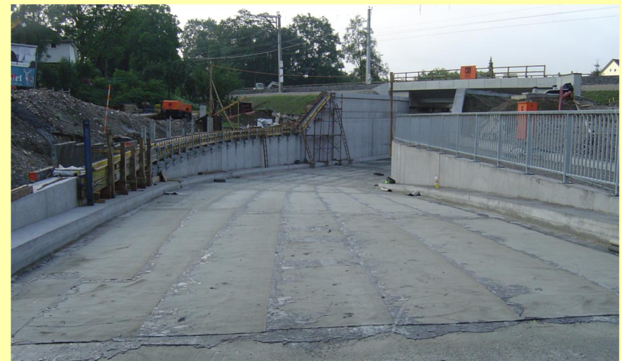
(Abb.: Unterführung in Arbeit)
