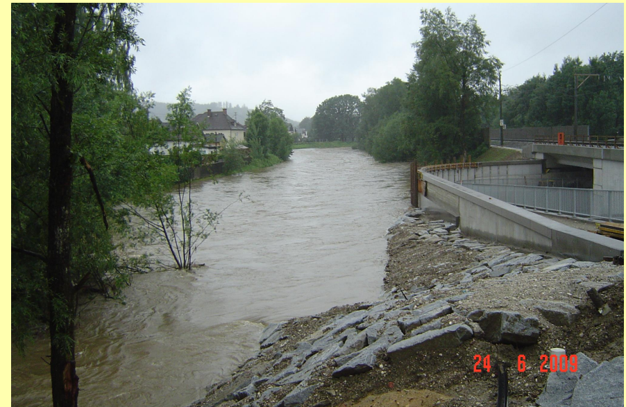
(Abb.: Hochwasserführende Vöckla im Bereich Bahnunterführung)
