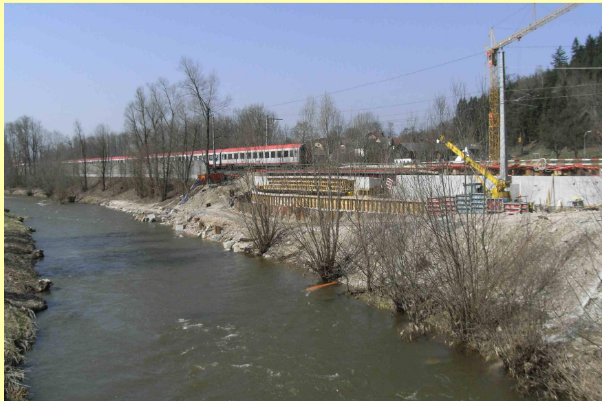
(Abb.: Blick über die Vöckla zur Unterführungsbaustelle)
