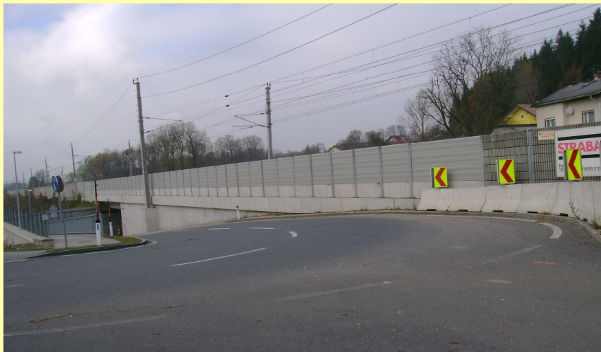
(Abb.: Lärmschutzwände entlang der Westbahn)
