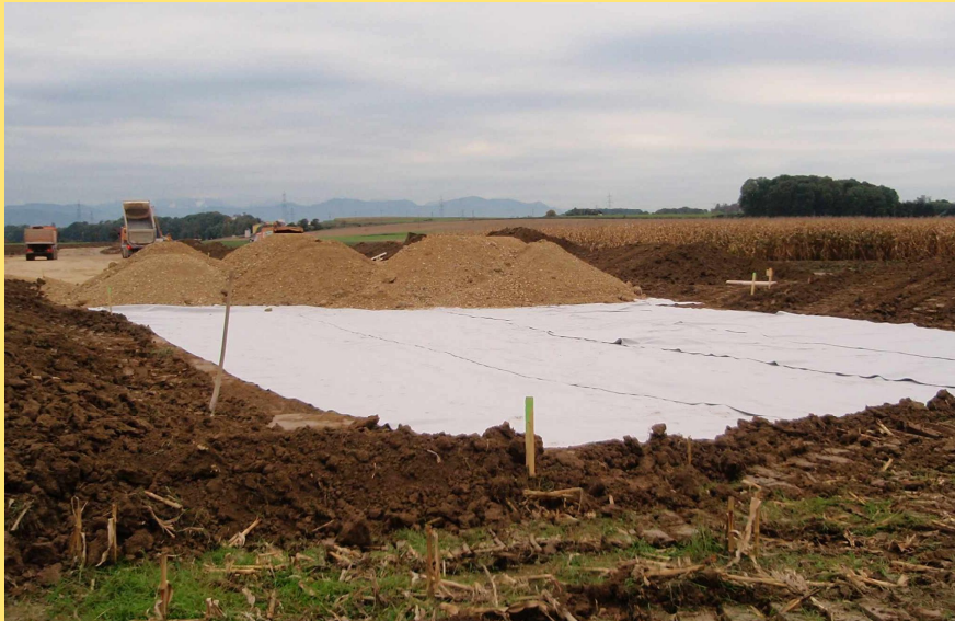
(Abb.: Bodenverbesserungsarbeiten Anschluss Kronstorf)
