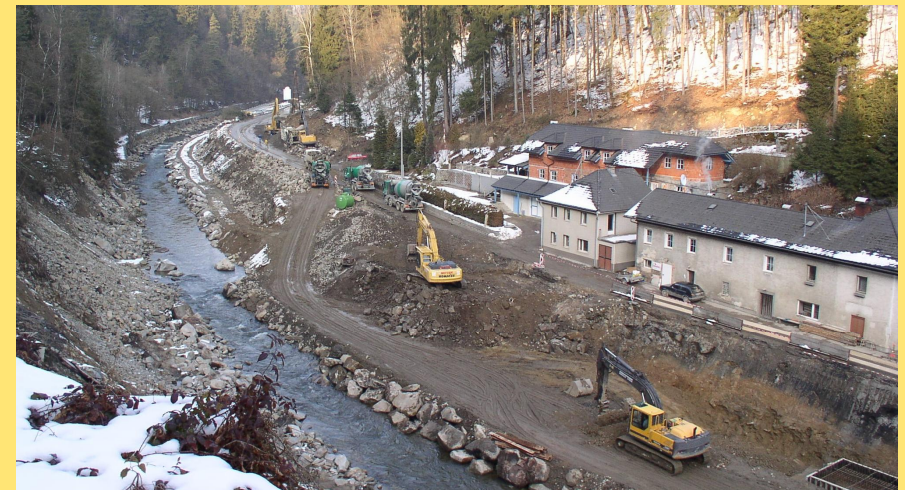
(Abb.: L 1415, 3. Bauabschnitt)
