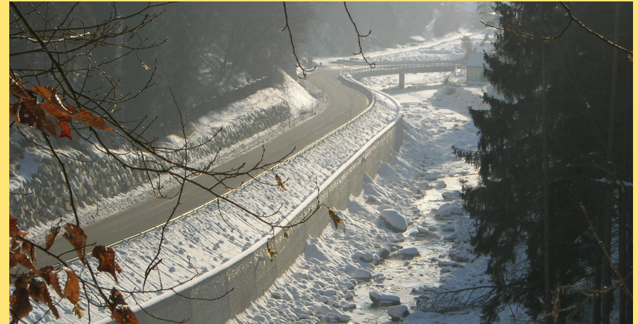
(Abb.: L 1415, 3. Bauabschnitt)
