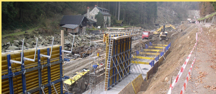
(Abb.: L 1415, 3. Bauabschnitt)
