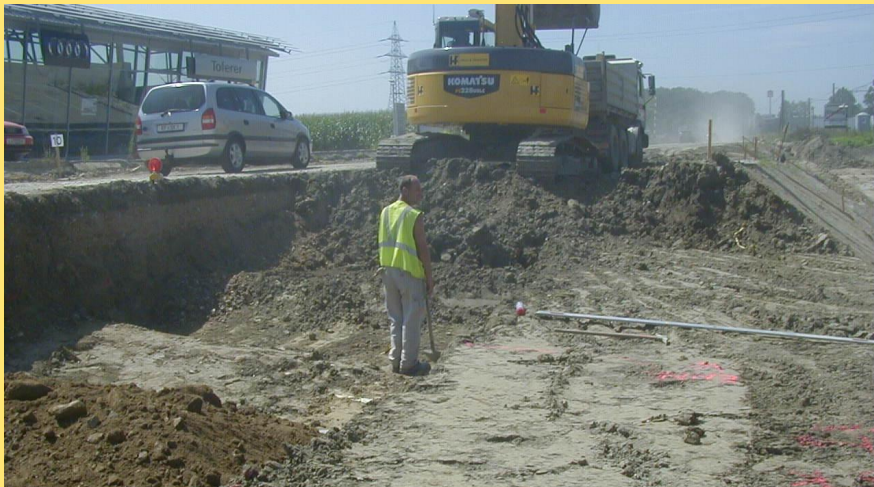
(Abb.: Bauarbeiten im Bereich Mercedes Toferer)
