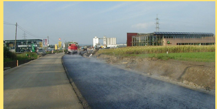
(Abb.: Asphaltierungsarbeiten B134)
