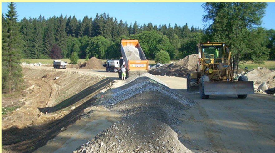
(Abb.: Bauarbeiten – Oktober 2010)
