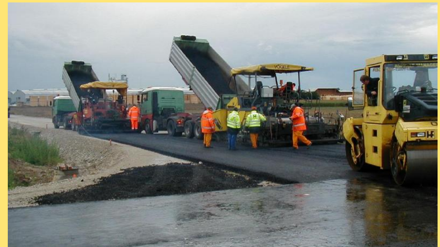
(Abb.: Asphaltierungsarbeiten)
