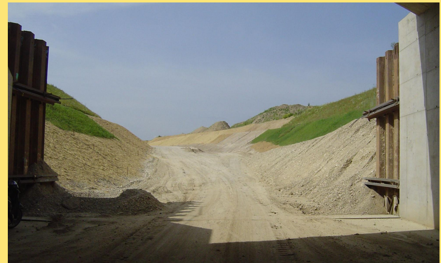
(Abb.: Blick aus der Westbahnunterführung auf die begrünten Böschungen)
