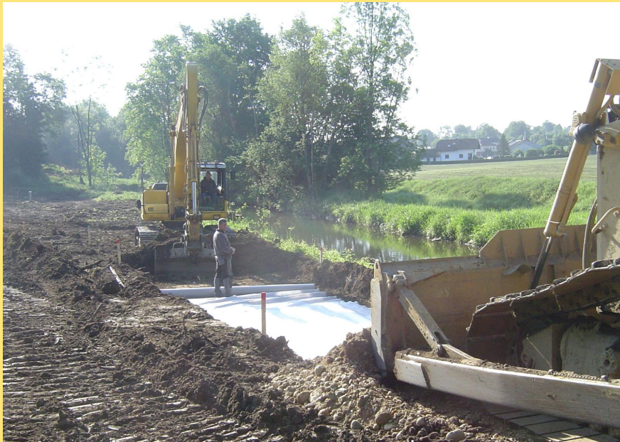
(Abb.: Arbeiten im Bereich des Schwaigerbaches)
