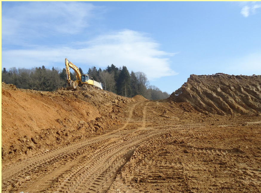
(Abb.: Erdarbeiten im Bauabschnitt Ost)
