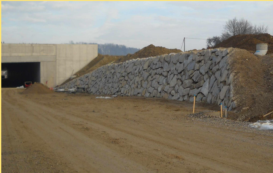
(Abb.: Steinschichtung Bereich Grünbrücke Metz)
