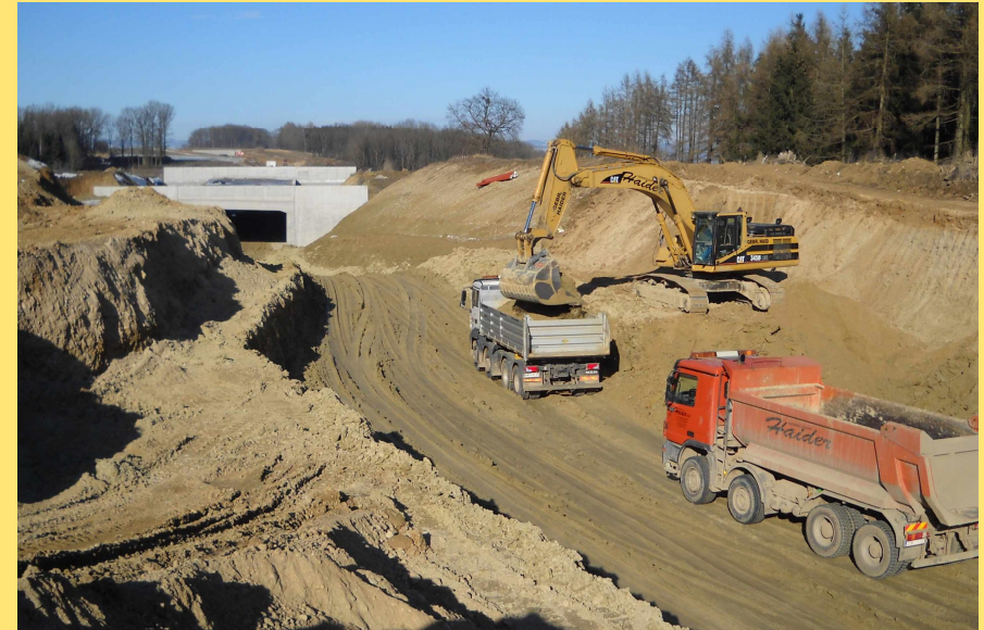
(Abb.: Abtragarbeiten Bereich Rabenberg)
