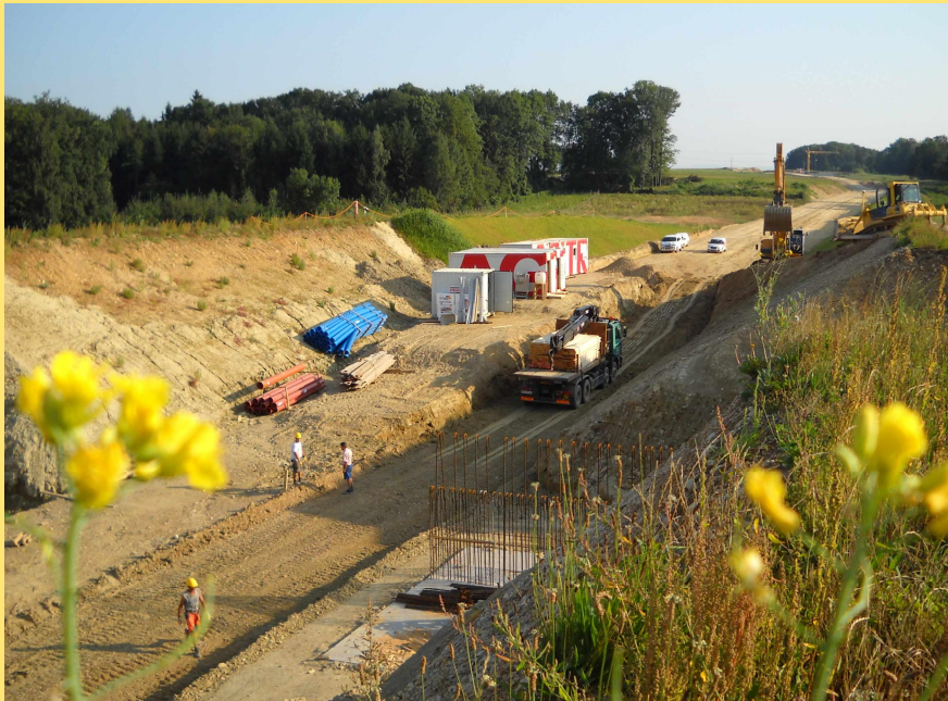
(Abb.: Bauarbeiten Bereich Grünbrücke Fördermayr)
