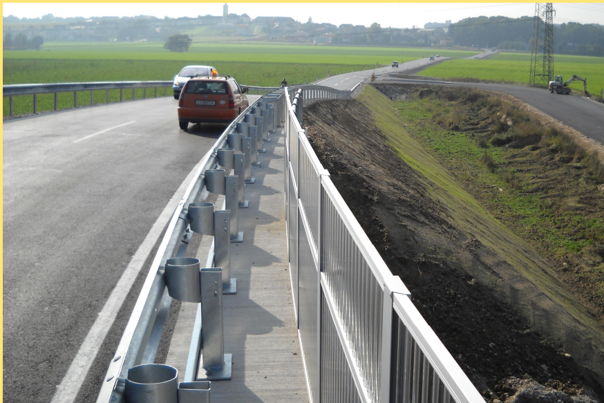
(Abb.: Überführung Hargelsberg)
