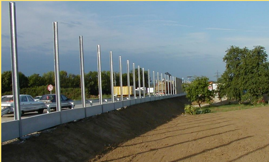
(Abb.: Errichtung der Lärmschutzwände)
