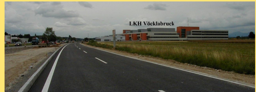
(Abb.: Blick von der Umfahrung auf das Landeskrankenhaus)
