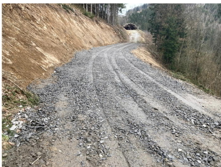
Durch den Katastrophenfonds mitfinanzierte Sanierung der Forststraße Dopplleiten im Februar 2024. Foto: Forsttechnischer Dienst BH Rohrbach
