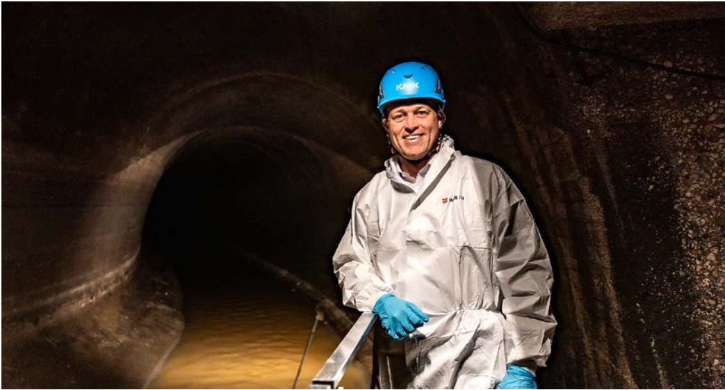
Umwelt- und Klima-LR Stefan Kaineder stieg in die Linzer Kanalisation ab.
