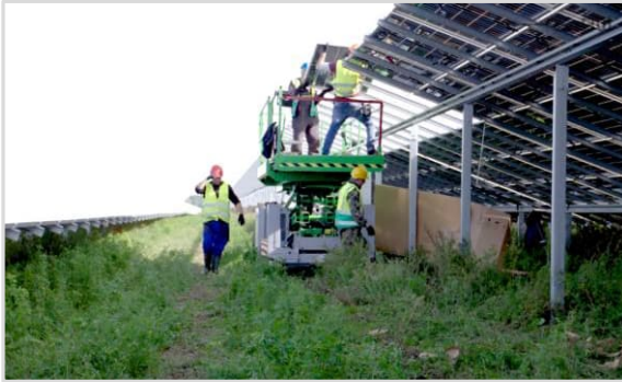
Abbildung 33: Einsatz eines kleinen, leichten Raupenfahrzeugs mit Hebebühne für die Installation der Module (© EnBW)
