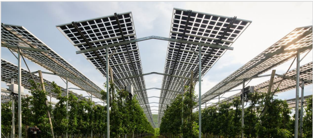
Abbildung 13: Mit Solarmodulen überspannte Apfelbäume des Obsthofes Bernhard am Bodensee als Teil des Forschungsprojekts „Modellregion Agri-Photovoltaik Baden-Württemberg“ (Quelle: ISE Fraunhofer)
