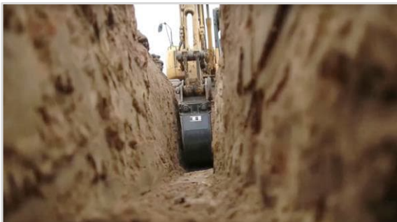
Abbildung 35: Bodenarbeiten für die Verlegung von Erdkabeln beim Bau einer Photovoltaik-Freiflächenanlage (© Enovos Energie Deutschland GmbH)
