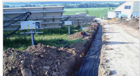
Abbildung 36: Erdkabeltrasse einer Photovoltaik-Freiflächenanlage (© Franke Elektrotechnik GmbH www.solarstrom.de )
