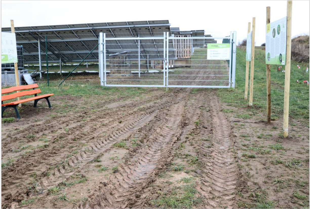
Abbildung 26: Einfahrtsbereich einer neu errichteten PV-Freiflächenanlage mit häufigen Überfahrten sowie Befahrung mit schweren Maschinen/Radfahrzeugen und entsprechend Fahrspuren und sichtbaren Bodenverdichtungen (© Baader Konzept GmbH)
