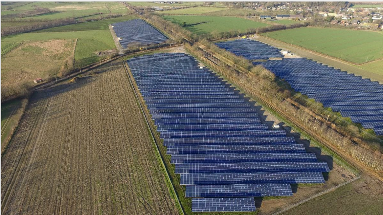
Abbildung 18: Photovoltaik-Freiflächenanlage entlang einer Eisenbahnstrecke (© F. Steinmann, LLUR)
