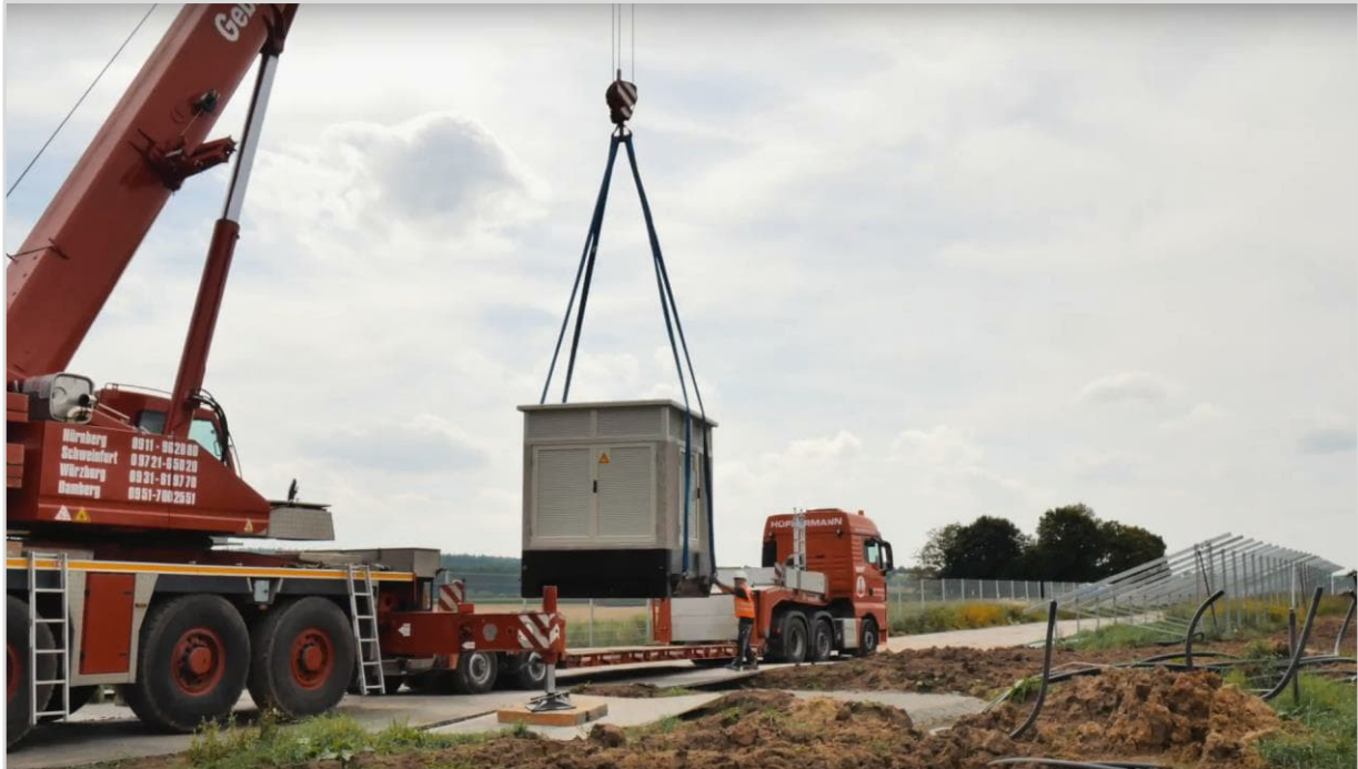
Abbildung 37: Anlieferung einer Übergabestation per Schwertransport auf Bodenschutzplatten (© JUWI / Ben Kremer)
