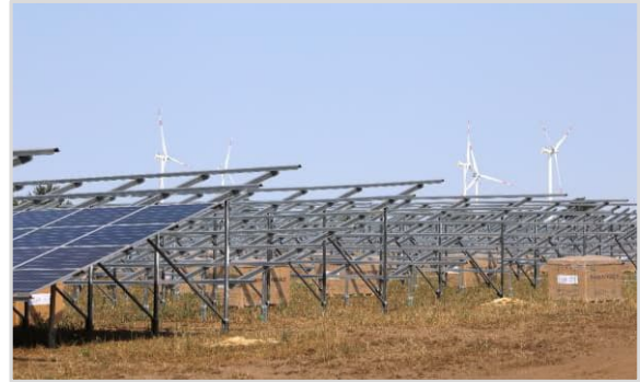
Abbildung 34: Montage der Solar-Module (© F. Steinmann, LLUR)
