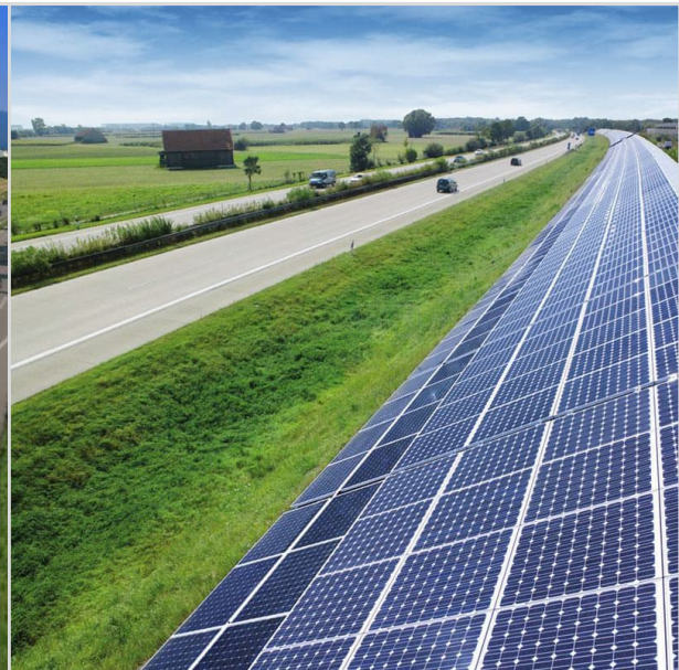
Abbildung 17: Photovoltaik-Lärmschutzanlage entlang der A92 bei Freising (ca. 1,2 km Länge) (Quelle: https://commons.wikimedia.org/w/index.php )
