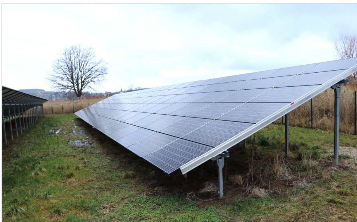
Abbildung 8: Starre Reihenanlage – Gründung mit Rammpfählen aus verzinktem Stahl (© Baader Konzept)
