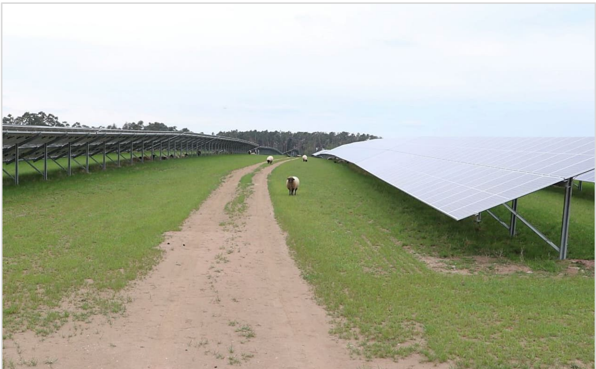
Abbildung 10: Großzügige Aufstellung mit ausreichender Höhe (für Beweidung) und weiteren Abständen der Modulreihen (© Baader Konzept)
