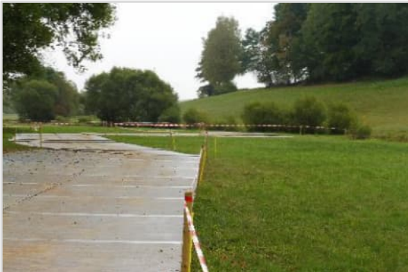
Abbildung 24: Bodenschutzplatten (Lastverteilungsplatten) zur Vermeidung von Bodenverdichtungen (© Schnittstelle Boden)
