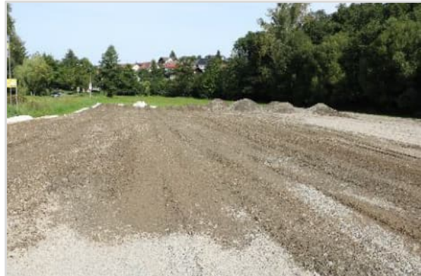
Abbildung 25: Geotextil und Schotterschicht zur Vermeidung von Bodenverdichtungen (© Schnittstelle Boden)
