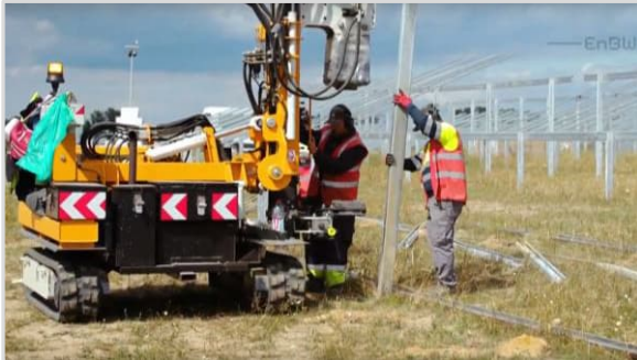
Abbildung 31: Einsatz eines kleinen, leichten Raupenfahrzeugs mit Hydraulikeinheit zum Rammen der Pfähle (© EnBW)
