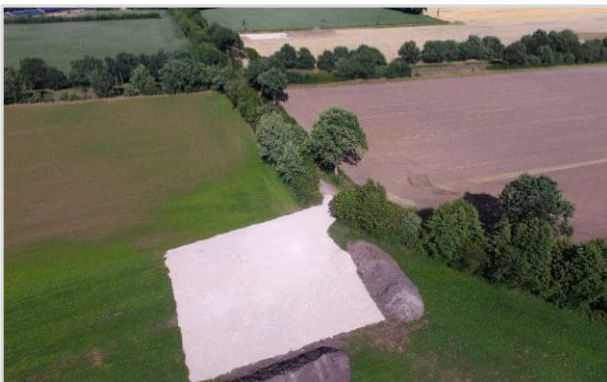
Abbildung 27: Baueinrichtungsfläche für Baucontainer und Baumaterial bei der Errichtung eines Solarparks (© F. Steinmann, LLUR)
