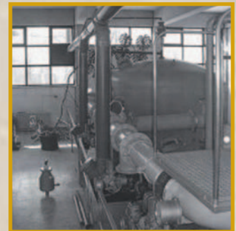
Radondichte Abtrennung von Spülkästen und Transport der Kesselluft durch Rohre direkt ins Freie
