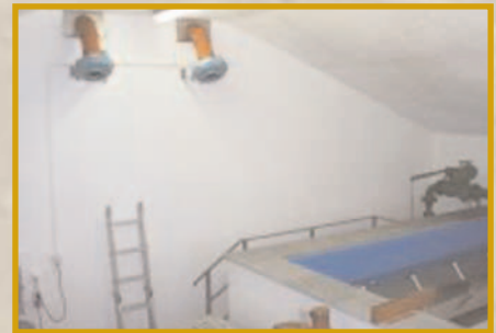
Einbau eines festen Ventilators
