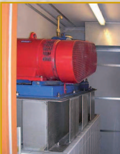
Bautechnische Abtrennung von einer Pelton-Turbine und Entlüftung in Freie
