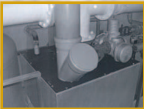
Radondichte Abtrennung von Spülkästen und Transport der Kesselluft durch Rohre direkt ins Freie
