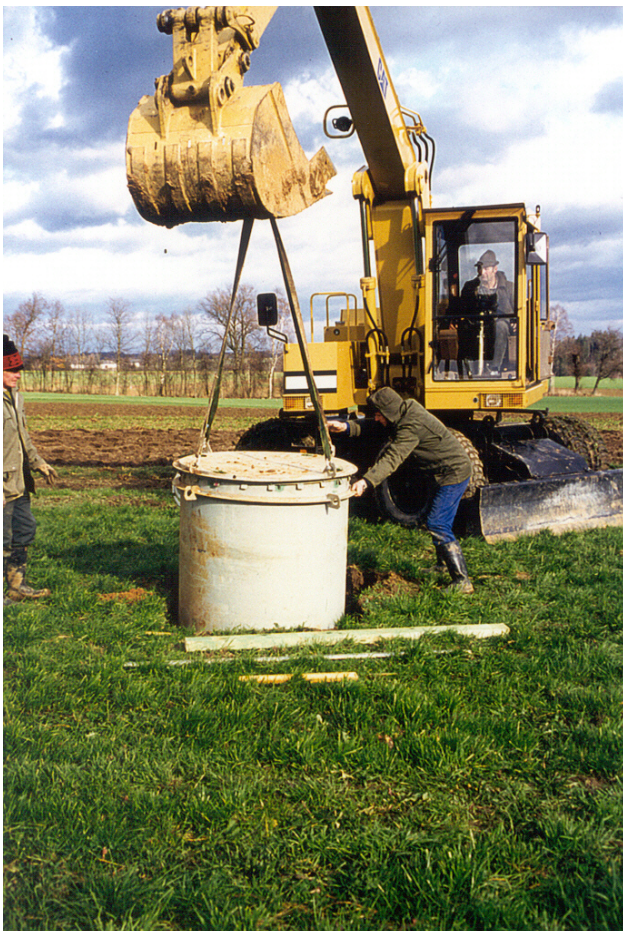
Abb. 2-1: Errichtung der Lysimeteranlage
