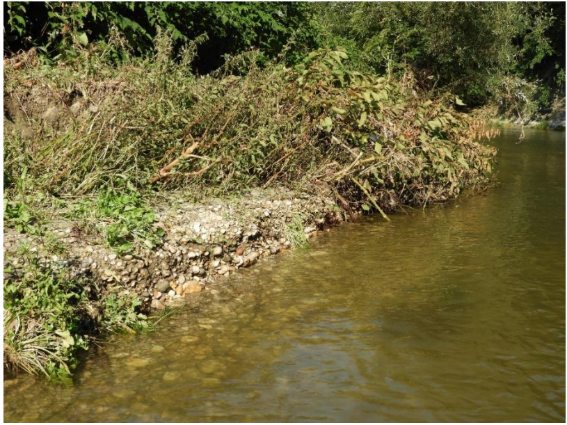
Abb. 12: Vom Hochwasser „bearbeitete“ Uferabbruchkante an Strecke F; 10.8.2020. Foto: A.Ch.
