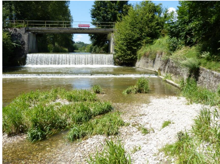
Abb. 77: Schotterbank unterhalb des Absturzbauwerkes (30.7.2016).
