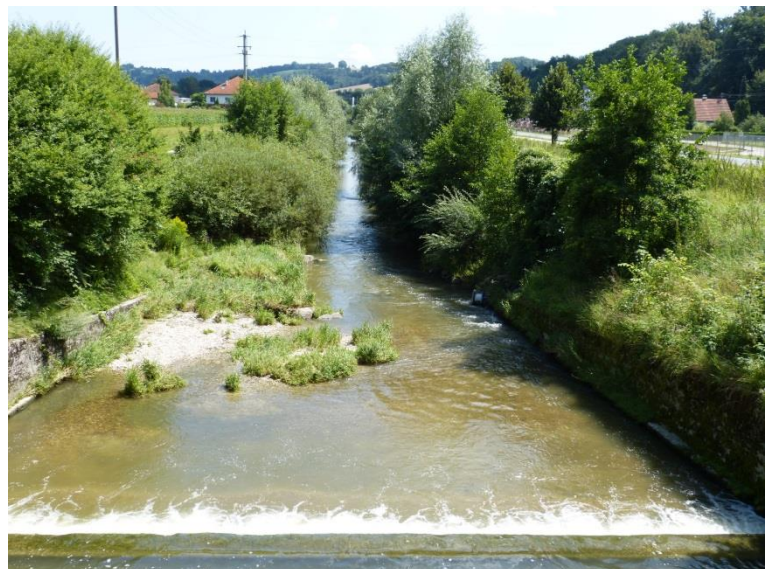
Abb. 76: Schotterbank unterhalb des Absturzbauwerkes (30.7.2016).
